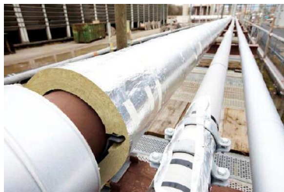
Şəkil 3 – Borunun daş yunu ilə izolyasiyanması Figure 3 – Insulation of the pipe with stone wool
