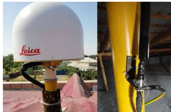
Şəkil 3 – Zaqatala stansiyasının qurulması Figure 3 – Construction of Zagatala station
